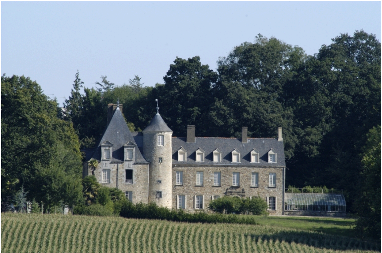
Vue générale sud
