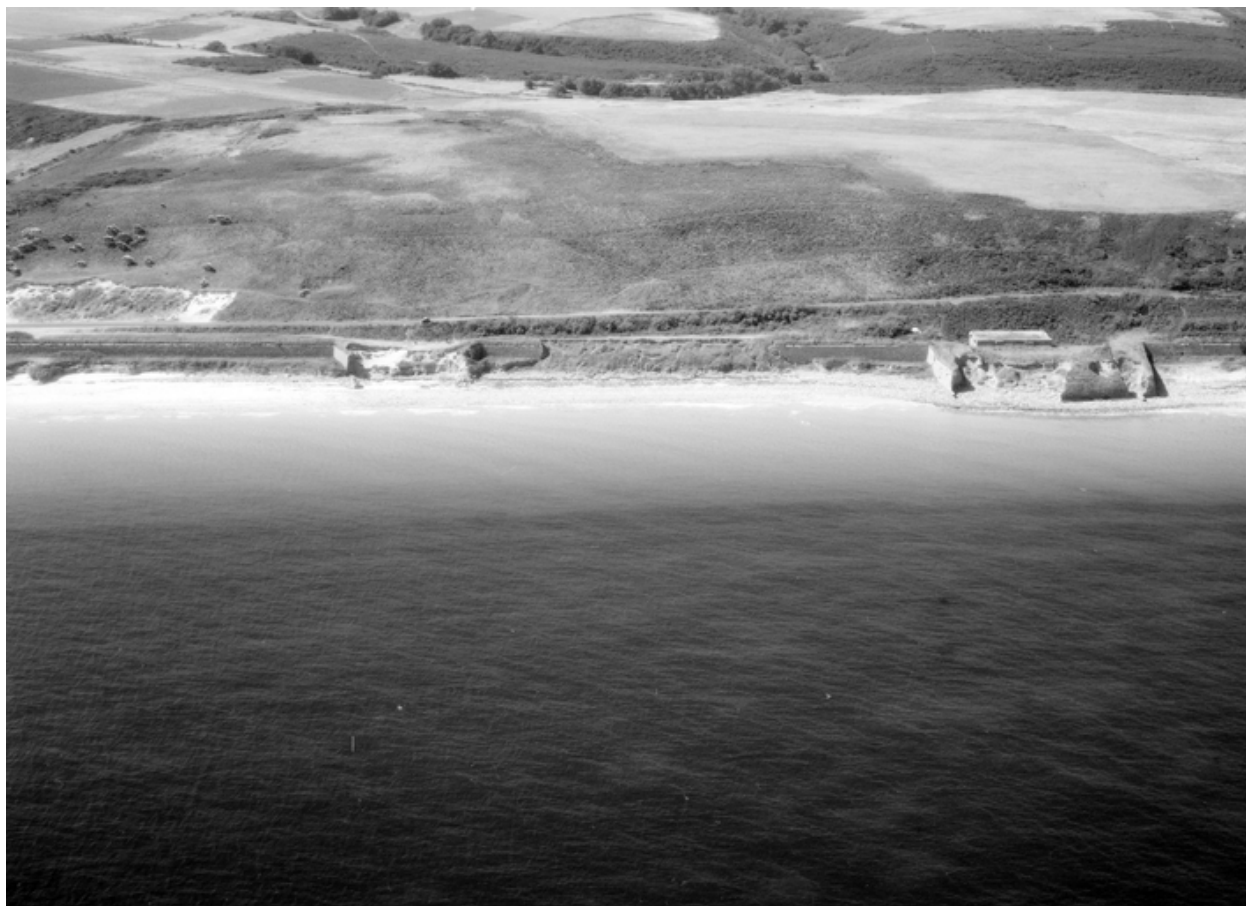
Vue aérienne prise du nord-est, partie centrale
