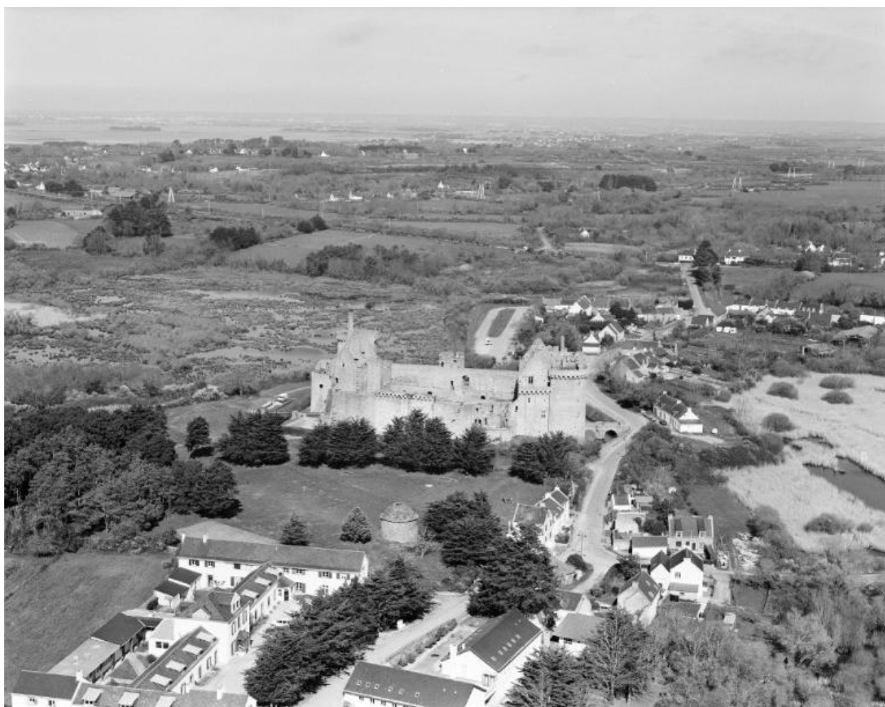
Vue aérienne sud
