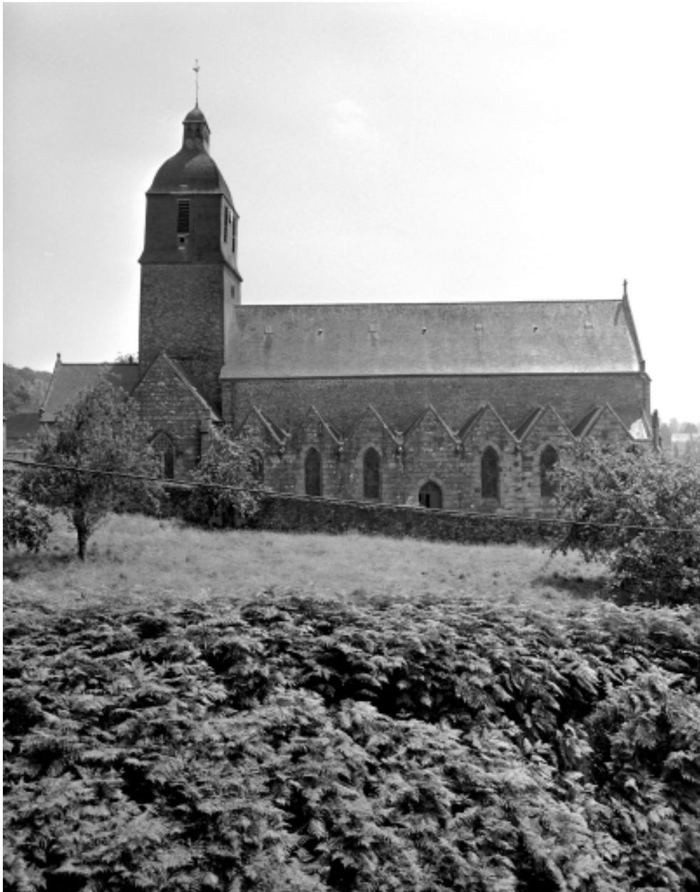
Elévation Nord : vue générale
