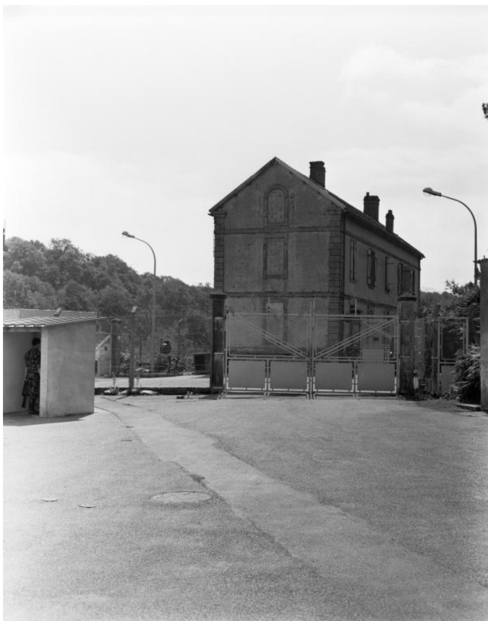
Maison de gardien, vue générale nord-est (état en 1998)
