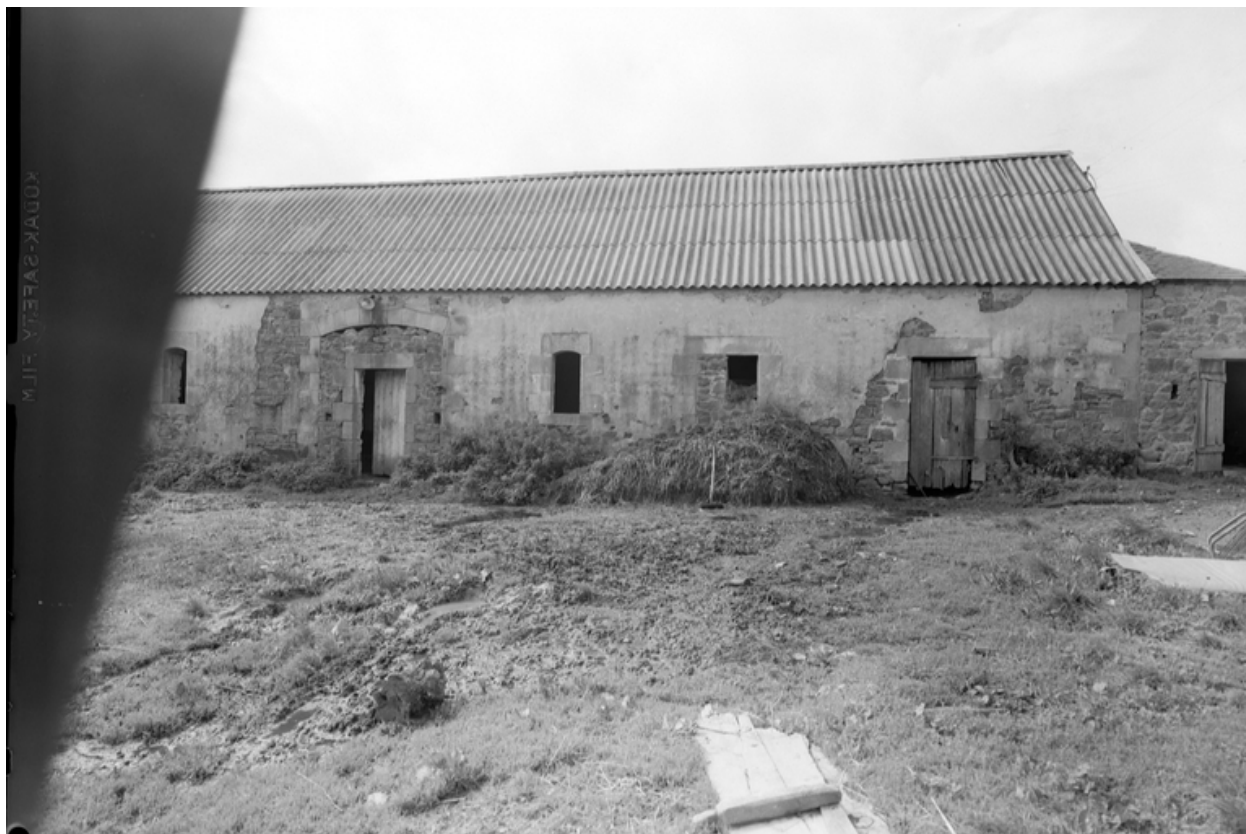
Vue de la face est du commun ouest
