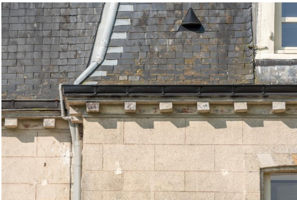
Façade est, détail des corniches
