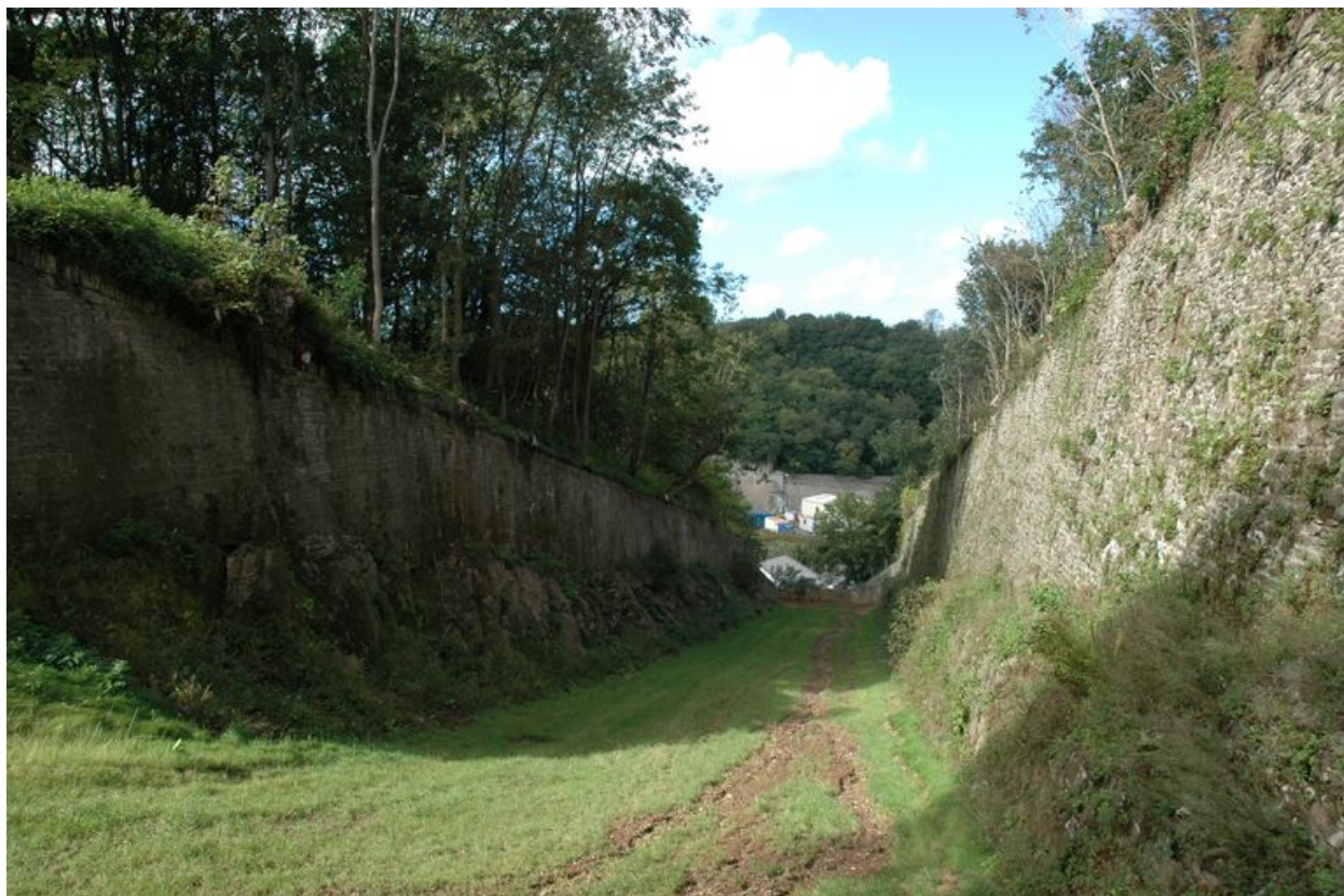
Vue de l'ouvrage à cornes de Quéliverzan
