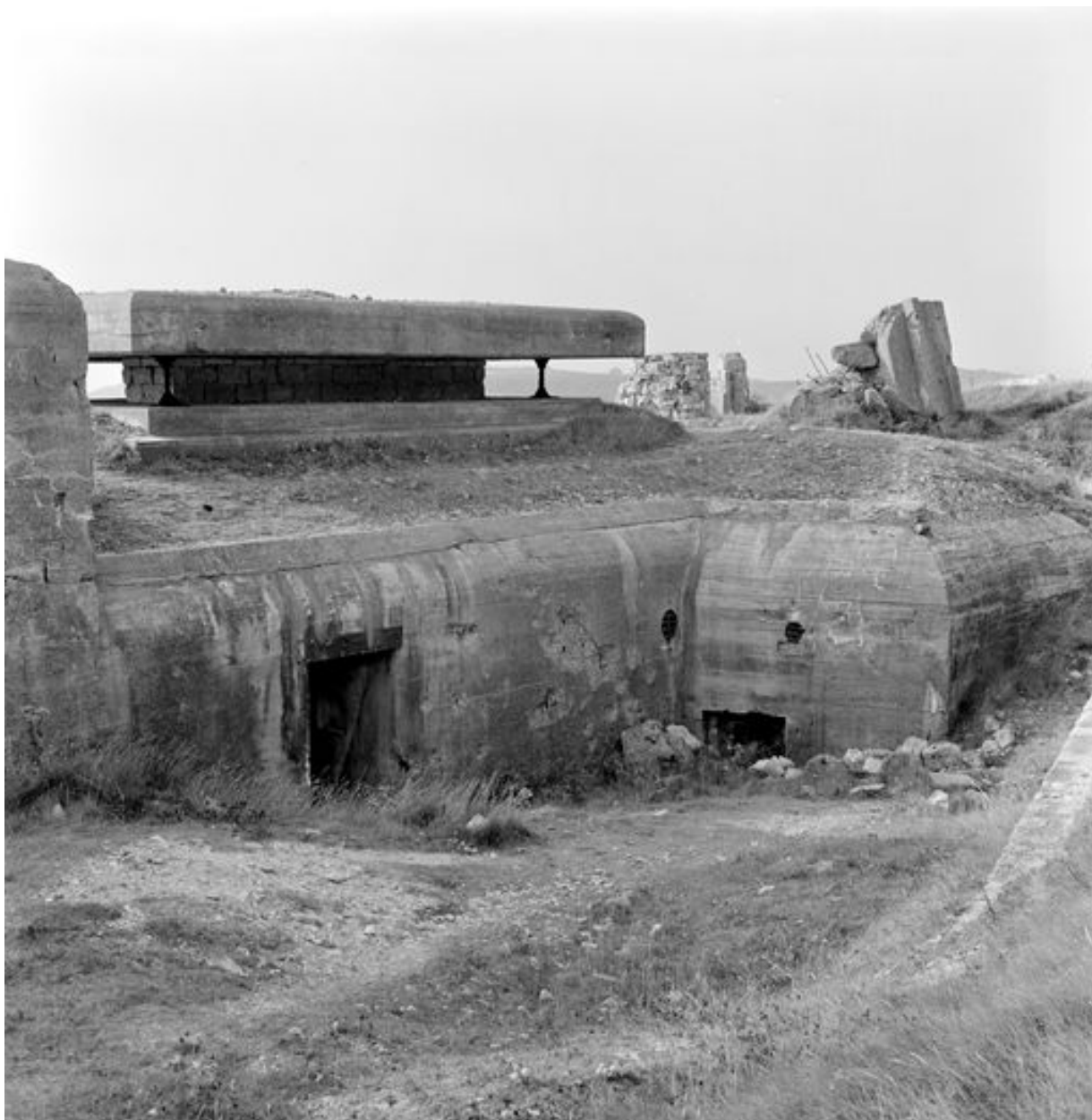
Vue de la batterie de Kerbonn en 1969 : façade arrière du bunker - poste de direction de tir de type M162a
