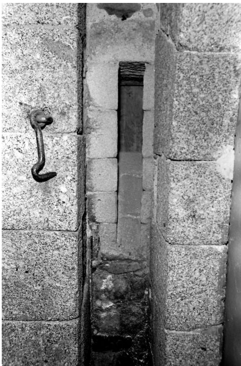
Vue du corps de garde crénelé n° 3 du bourg de Roscanvel en 1969 : intérieur, passage d'entrée percé par créneau de fusillade
