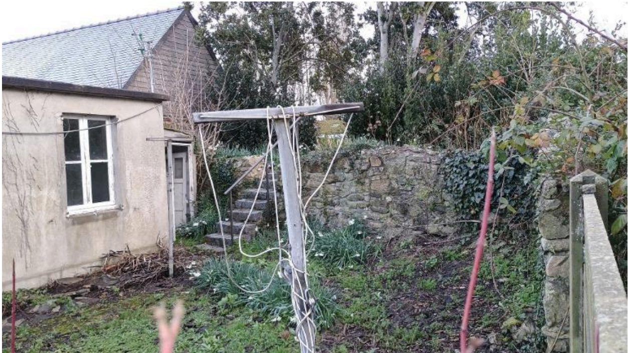
Vue des vestiges du mur de soutènement de la digue dans la parcelle section CA, n° 559 depuis la parcelle CA, n° 558
