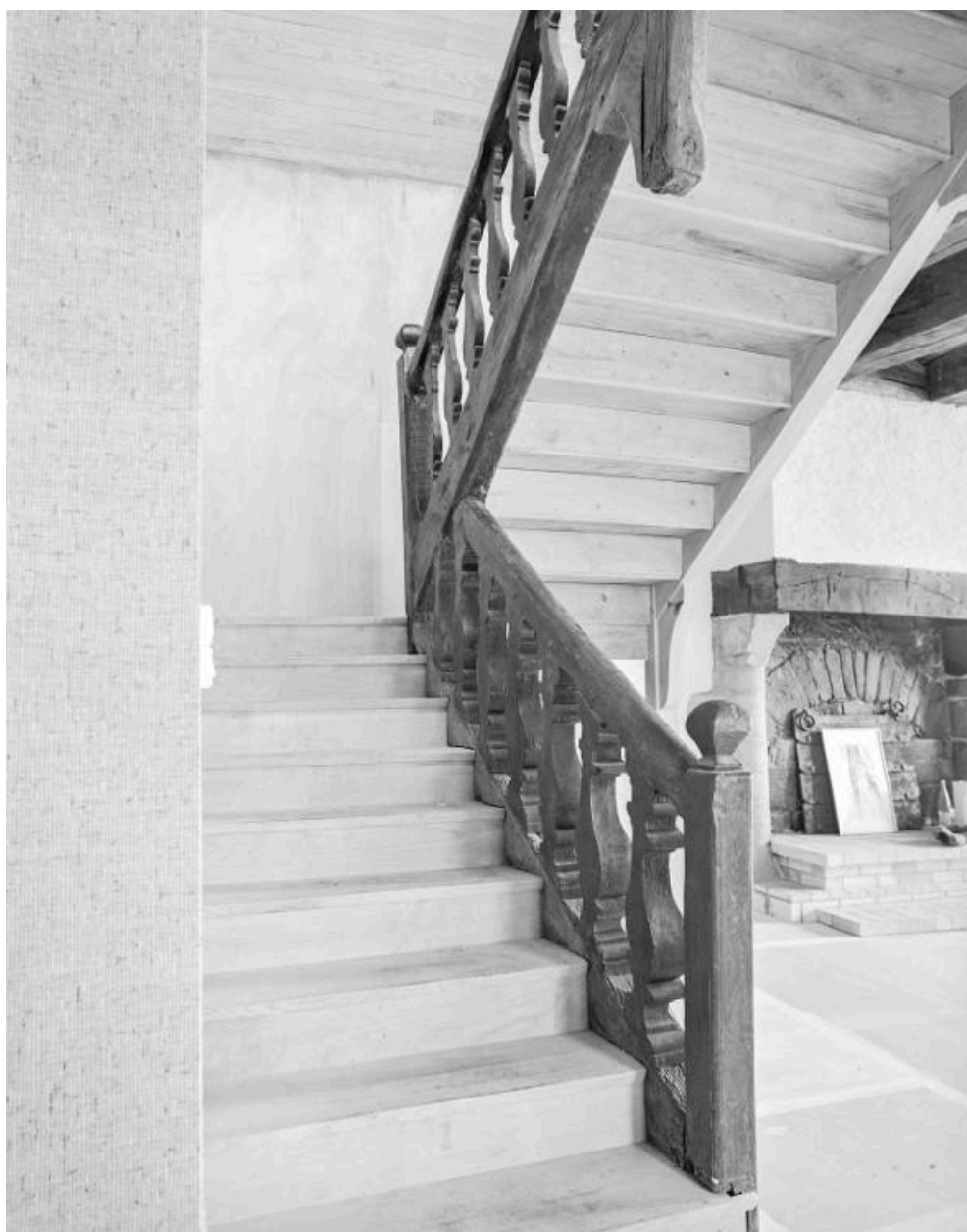
Escalier, garde corps à balustres découpés
