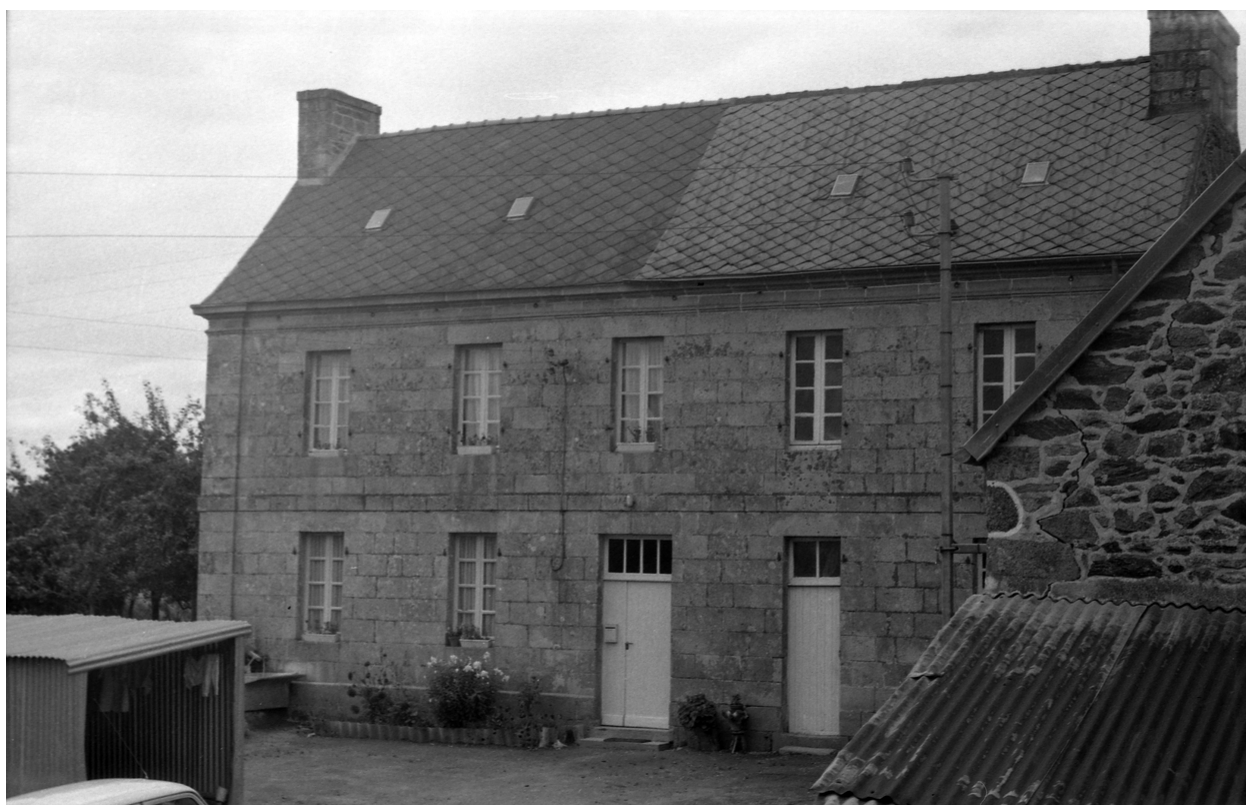
Vue générale de la façade sud
