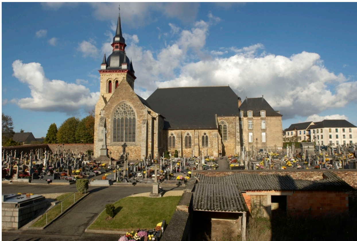
Vue générale sud
