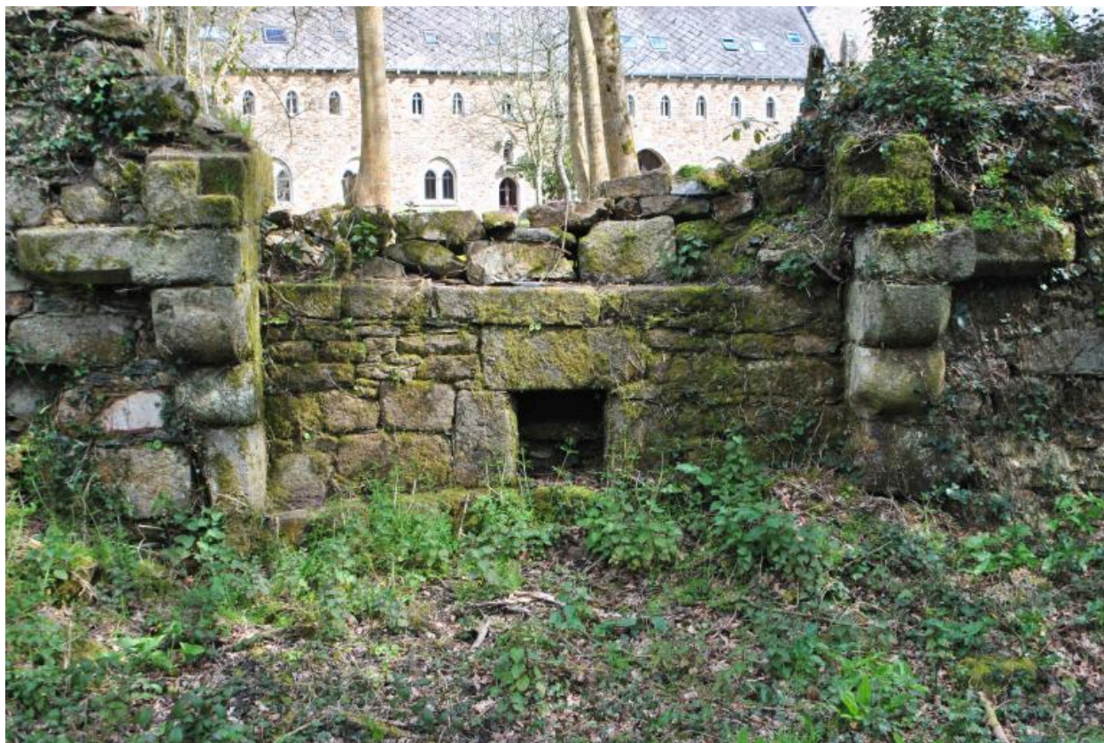
Cheminée à crossettes de l'ancienne boulangerie médiévale
