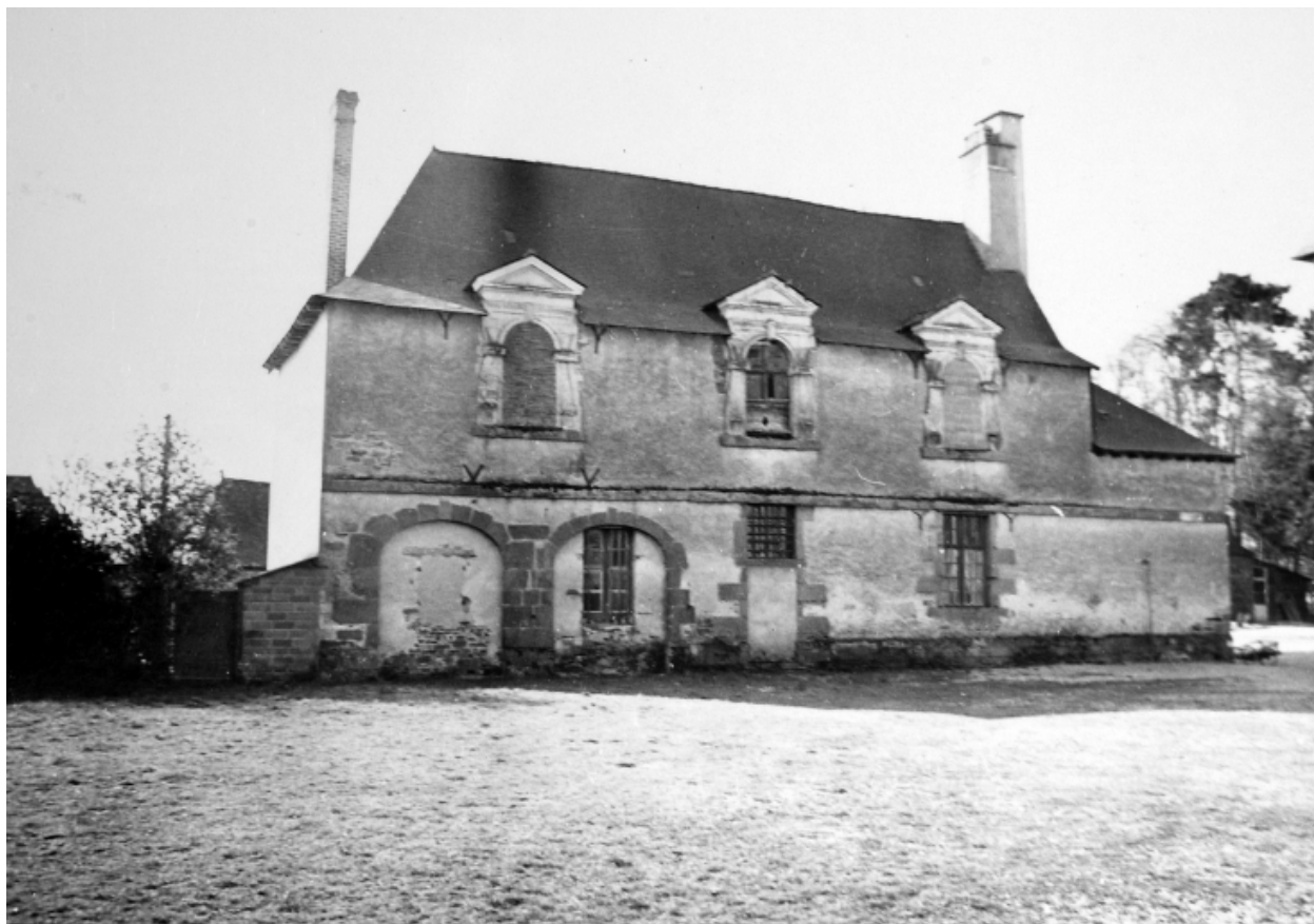
Métairie sud : le logis façade arrière sur cour (état en 1973)
