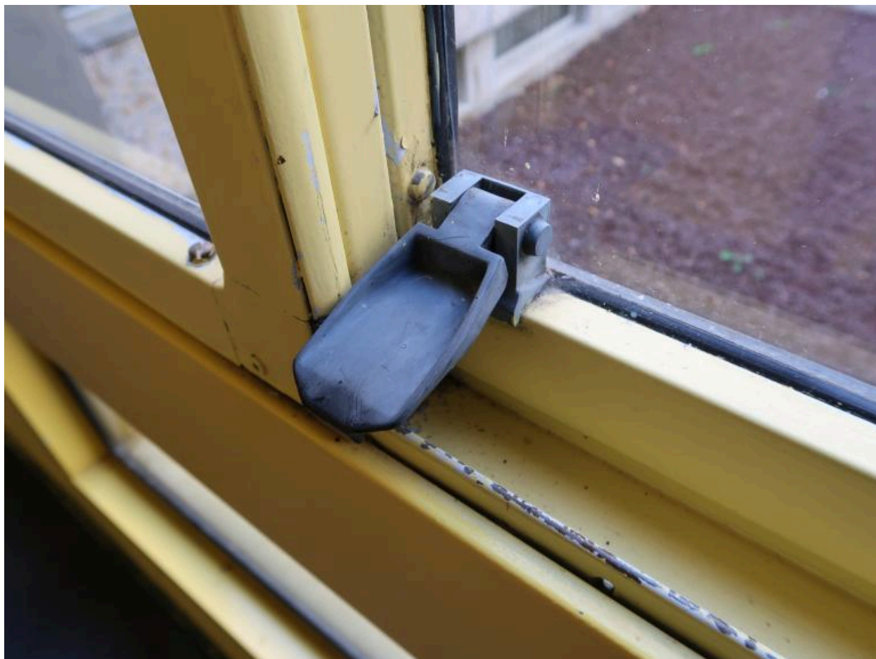
Internat (bâtiment I) : détail sur les menuiseries et le système de fermeture des fenêtres coulissantes (1975).
