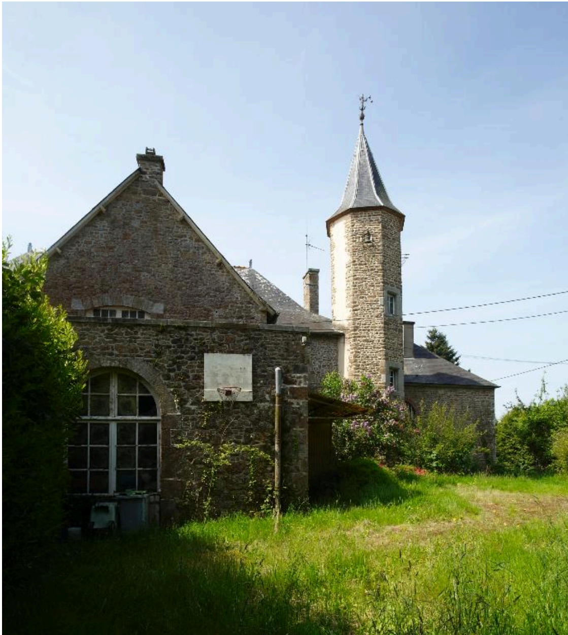
Vue sur la tour d'escalier
