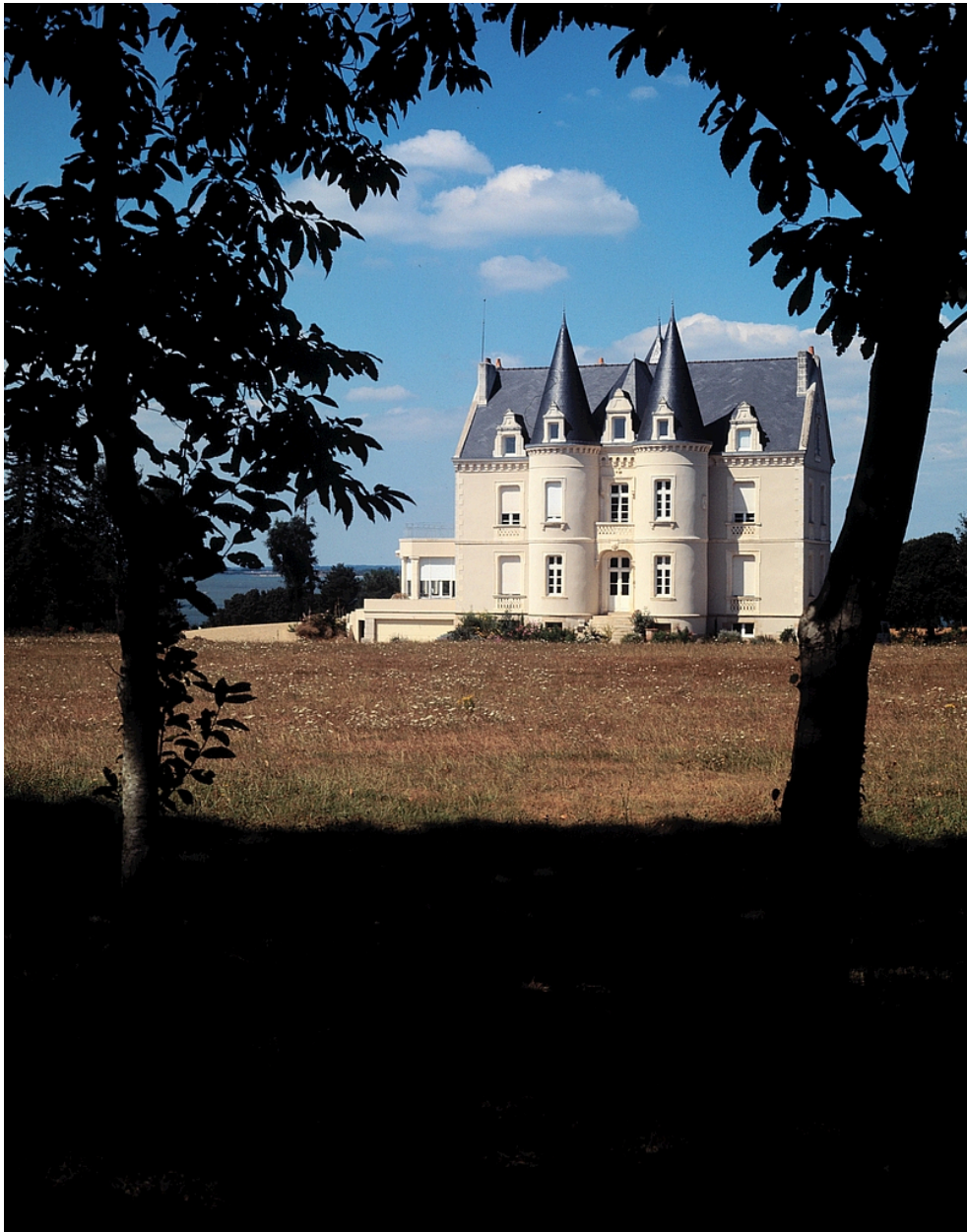
Château, vue générale sud.
