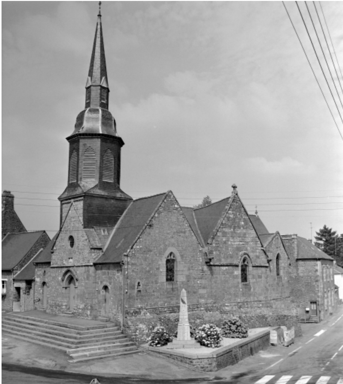
Elévation Sud-Ouest : vue générale
