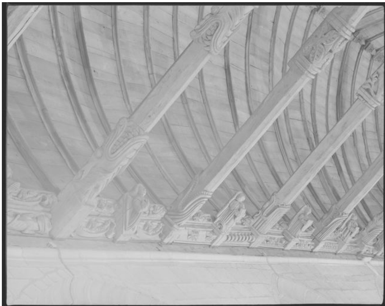
Sablières et entrait
