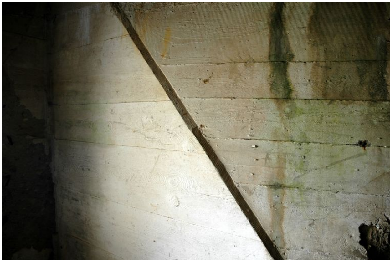
Vue de mur de la casemate en béton armé (état en 2005)
