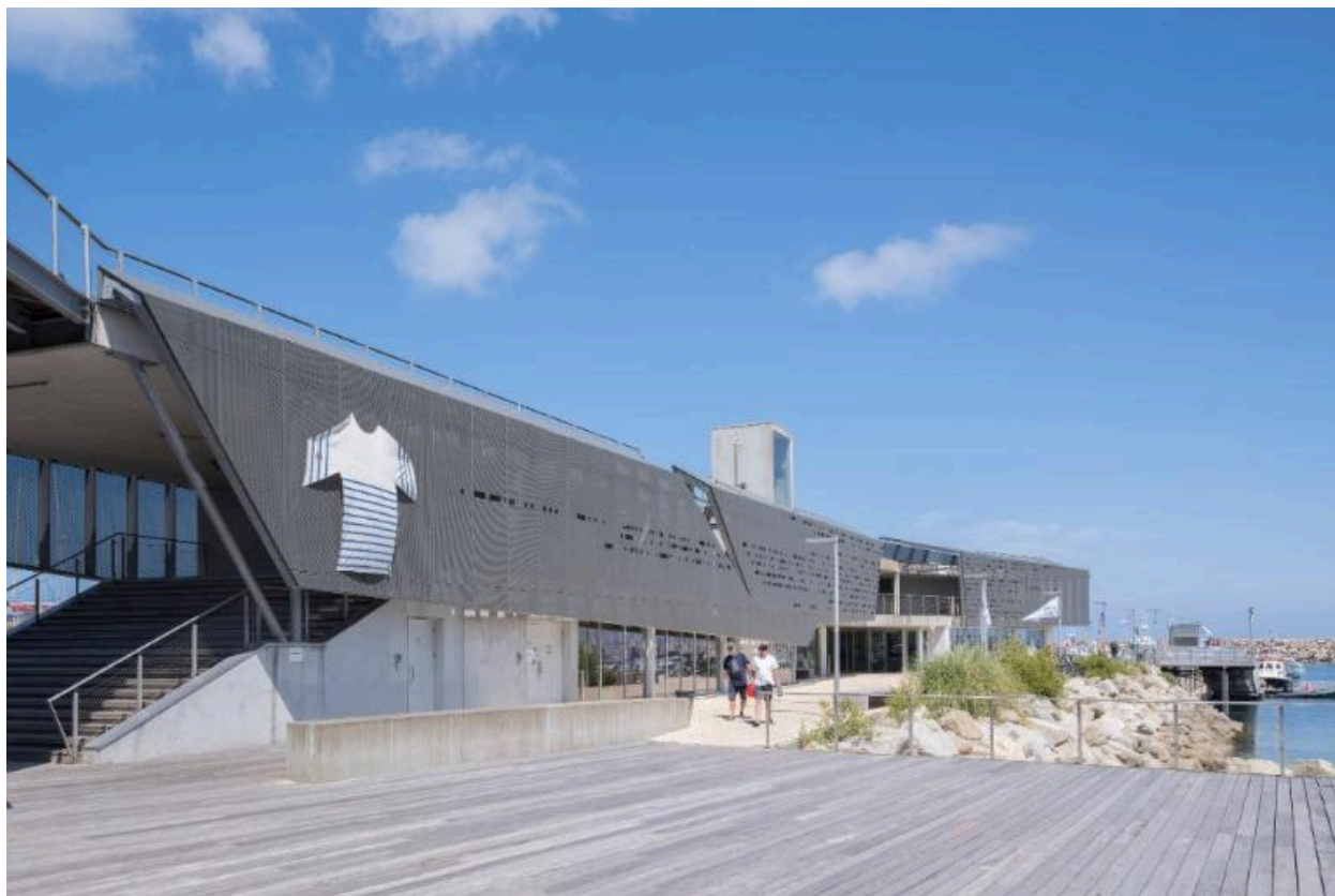
Espace commercial du port de plaisance de Roscoff
