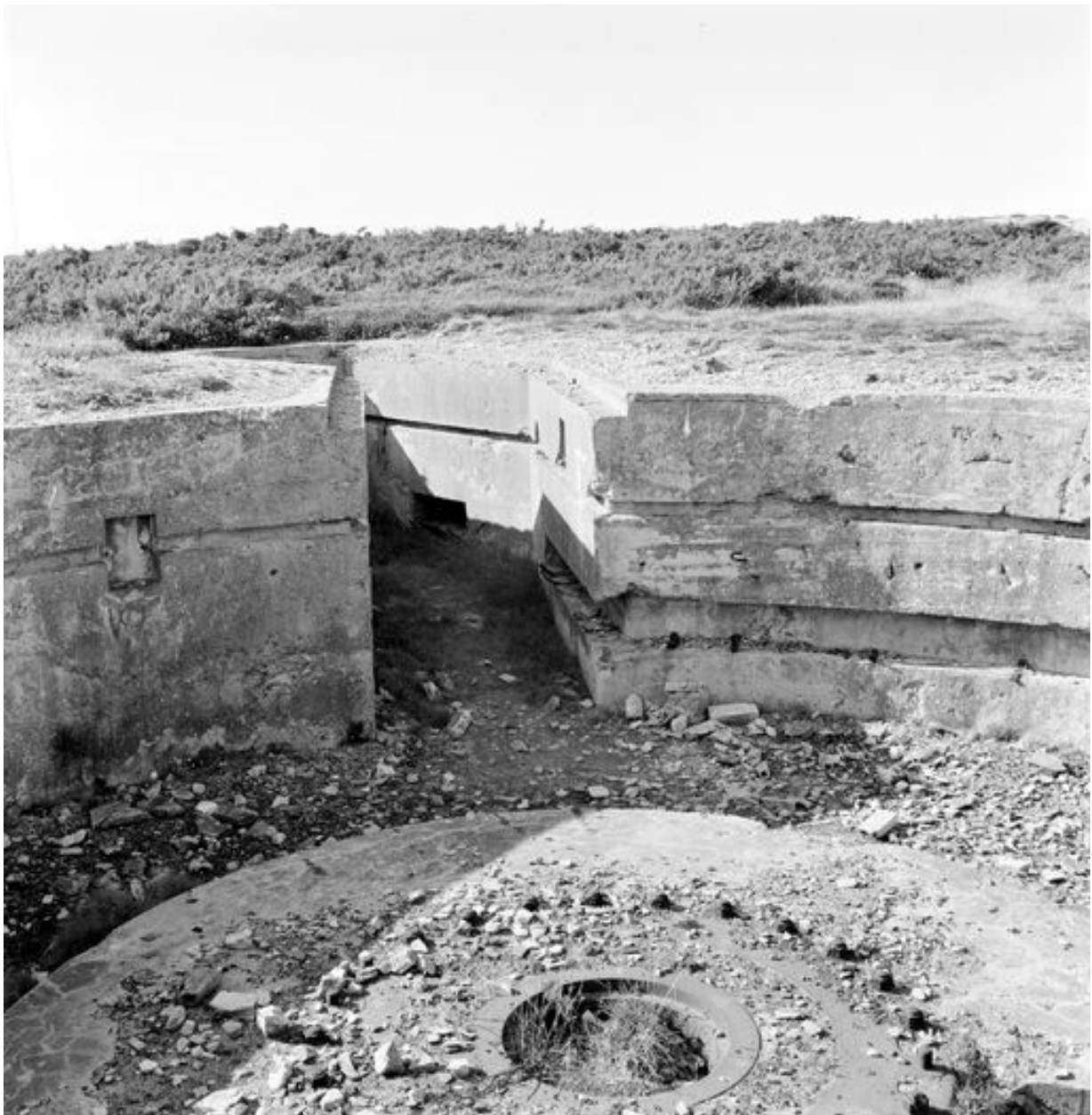
Vue de l'une des quatre cuves à canon (état en 1969)
