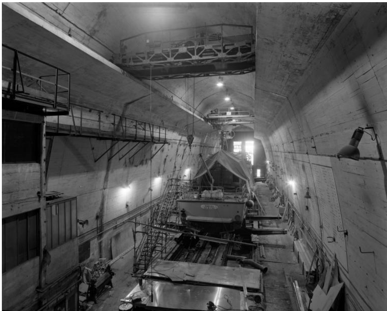
Vue générale de la nef vers le nord (état en 2000, chantier naval en activité) : navire en réparation. Au plafond, le pont roulant et son treuil en fonctionnement
