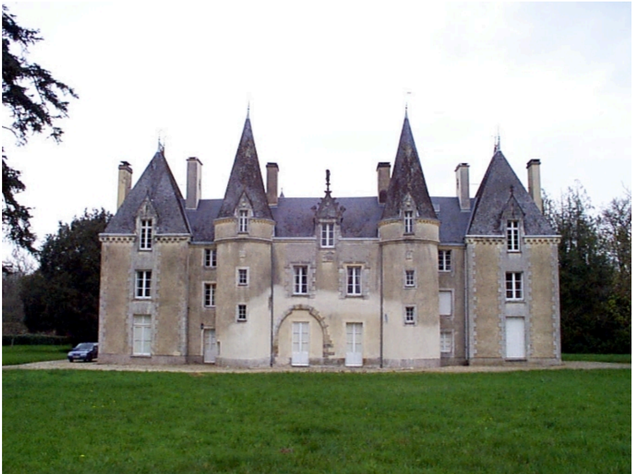
Façade principale : vue générale sud
