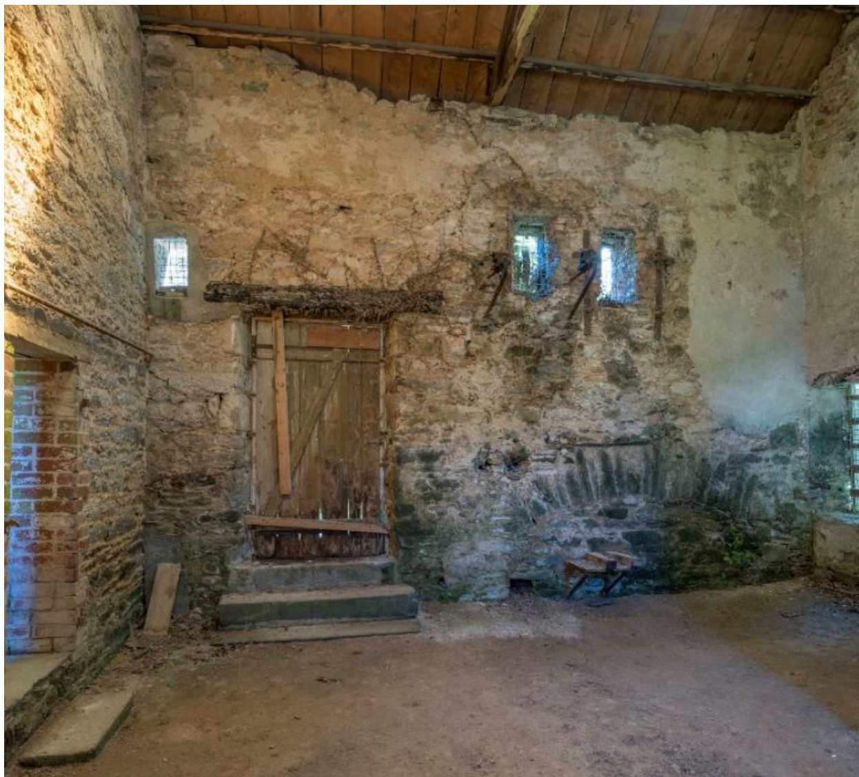
Bâtiment principal. Salle 1. Mur arrière sud-est avec traces d'ouverture du moulin à papier
