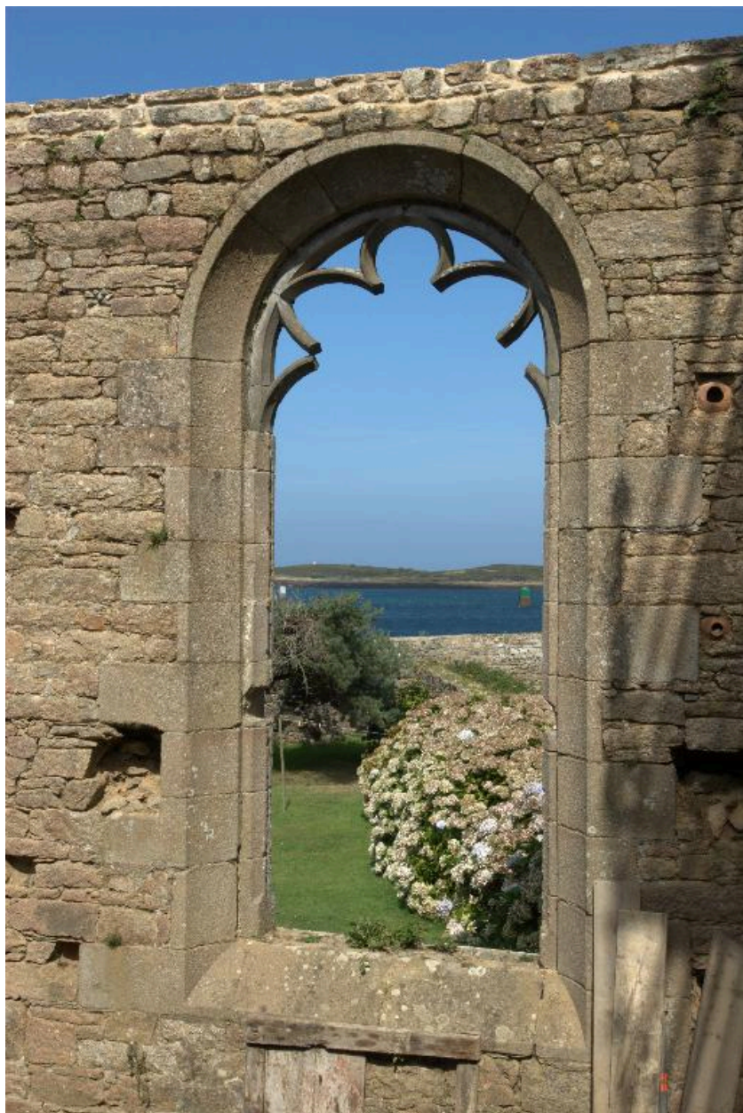
Vue du fenestrage sur le mur nord de la chapelle
