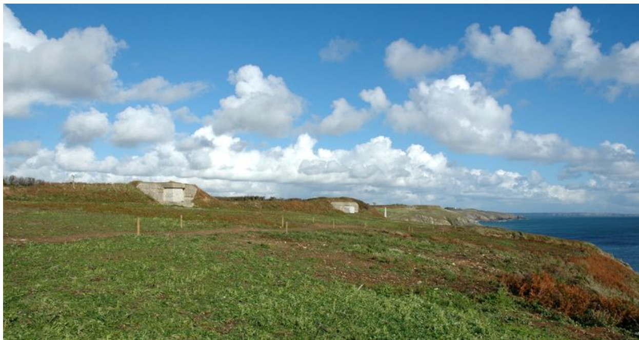
Vue générale des casemates n° 3 et 4
