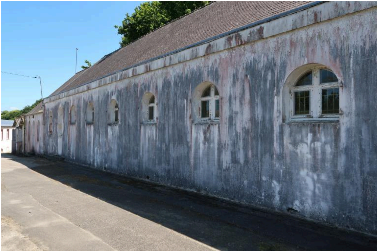
Vue générale : élévation nord avec petites baies à linteau en arc plein cintre (état en 2022)
