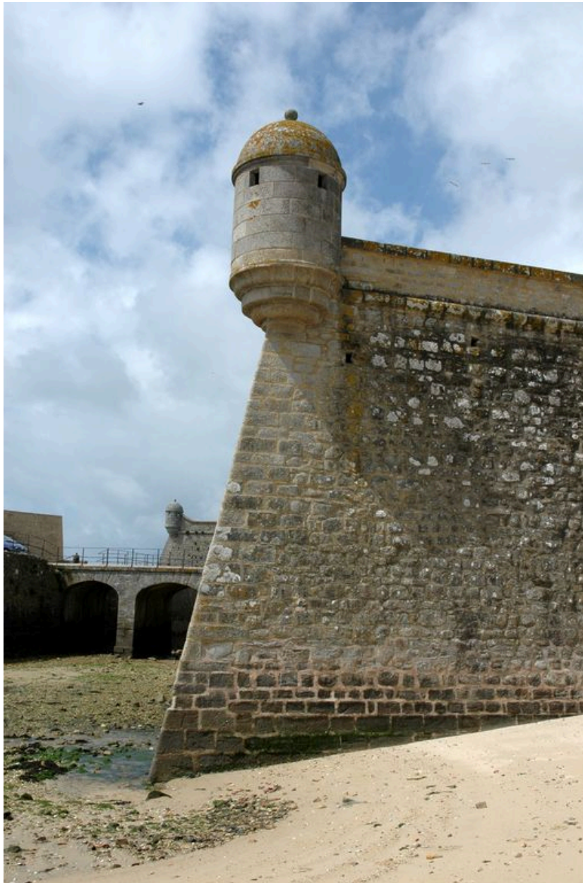
Vue de la citadelle de Port-Louis : échauguette de la demi-lune. En arrière-plan : le pont-dormant de la demi-lune et l'échauguette du bastion de Groix
