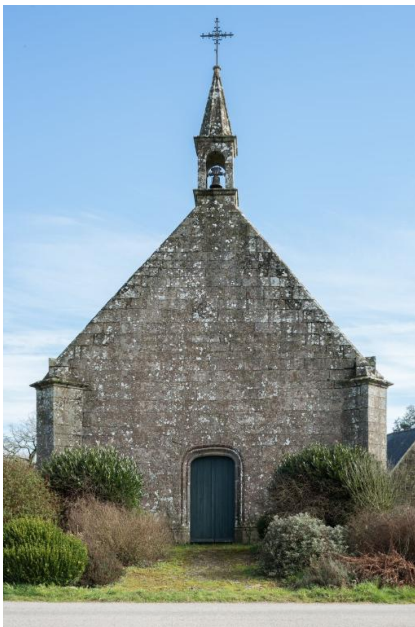
Vue de la façade ouest de la chapelle
