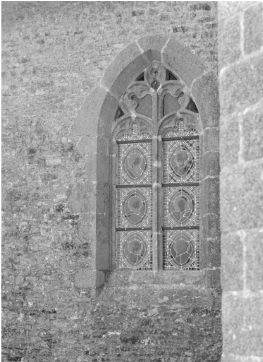
Mur nord du choeur, vue générale de la fenêtre
