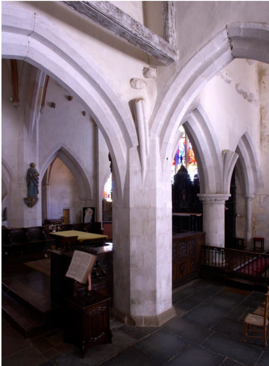
Collatéral sud et chapelle sud. Détail des arcades
