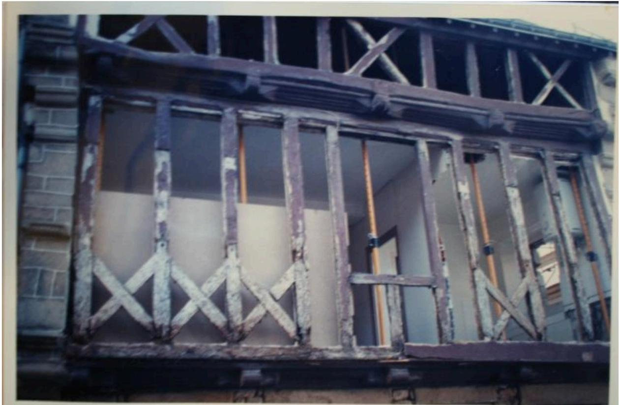
Mise à nu de la structure pan de bois avant restauration. Les poteaux de l'étage définissent neuf travées surmontées d'un chanfrein sur la sablière de plancher du surcroît.
