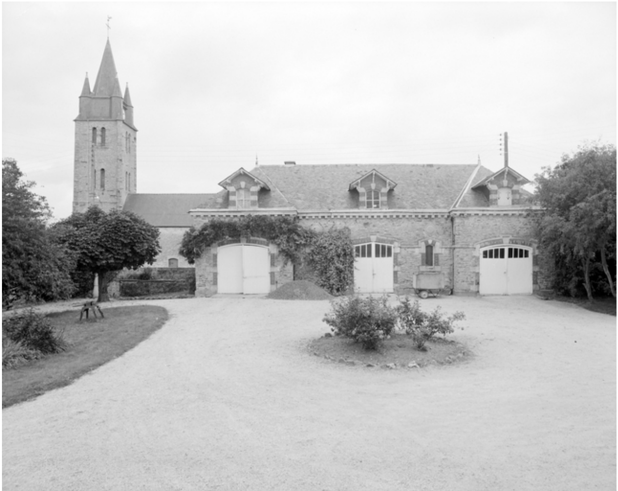
Dépendances : vue générale sud.
