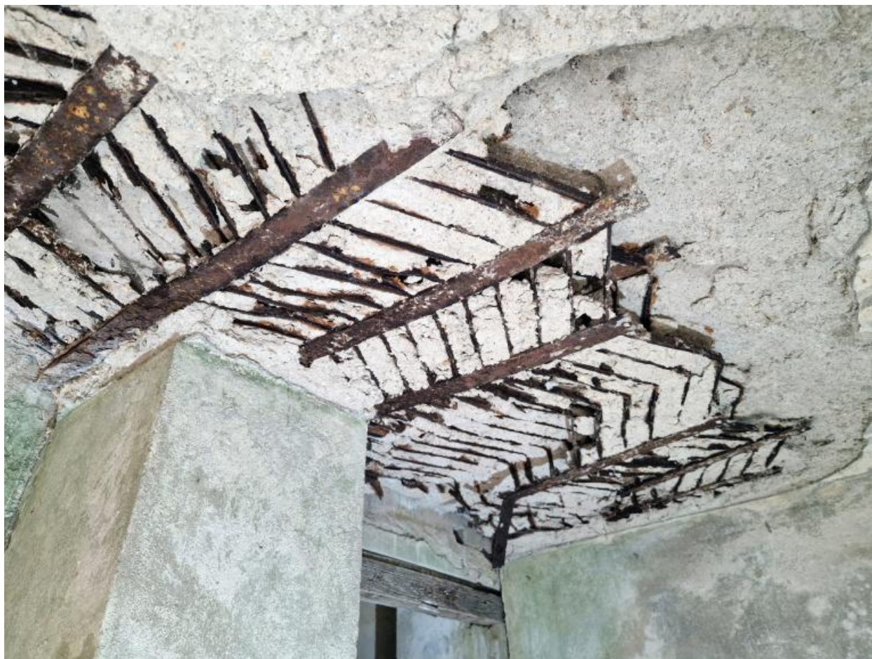
Vue du ferrailage de la dalle de couverture composé de grilles métalliques de roulement pour piste d'avion
