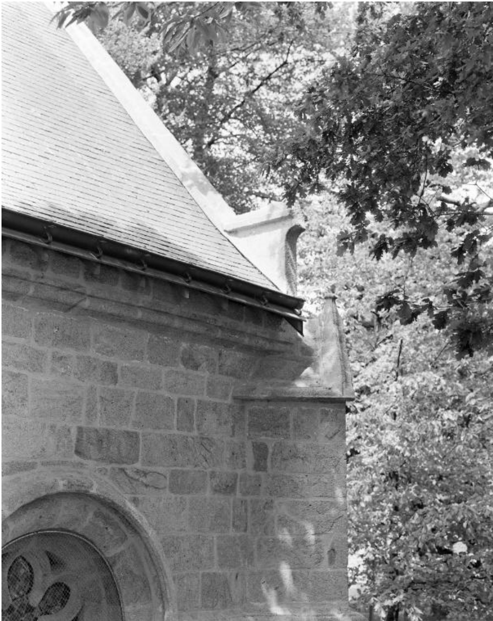
Bras nord, détail du rampant est et du contrefort est.
