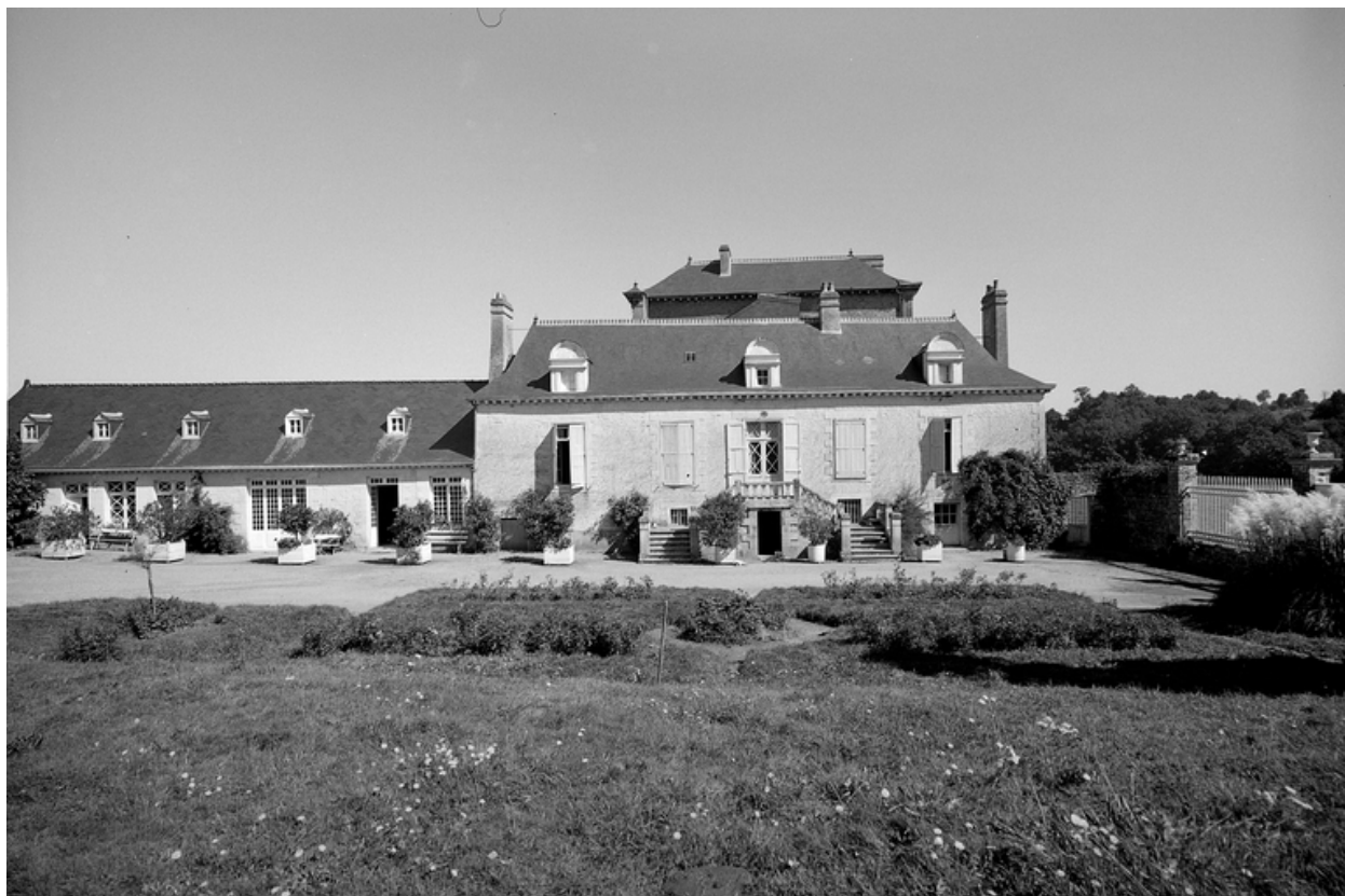
Façade principale, vue générale.
