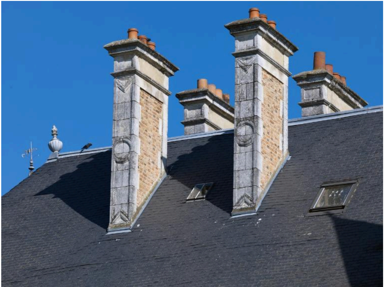
Souches de cheminée
