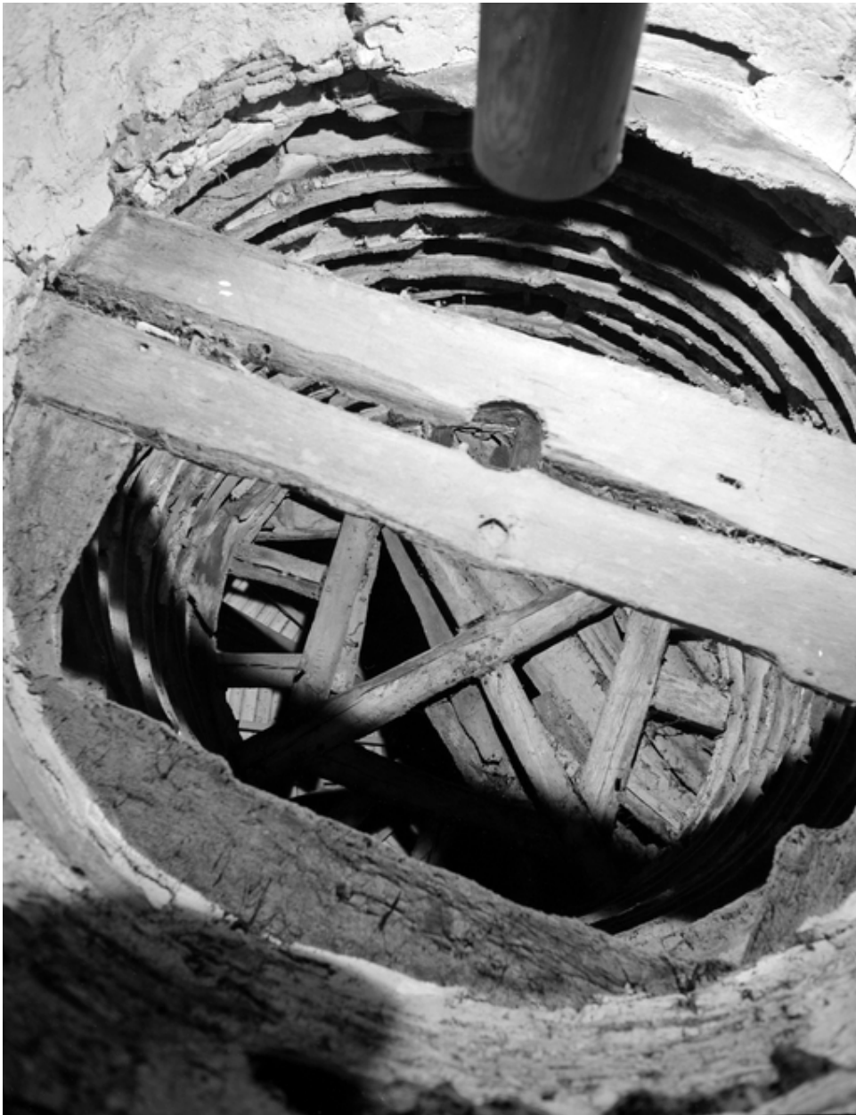
Charpente de la tourelle.
