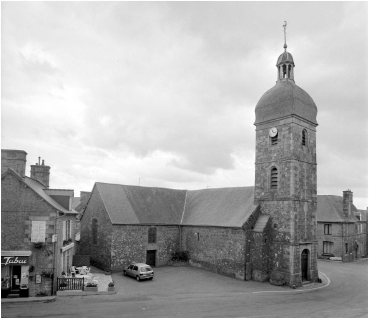
Elévation Nord-Ouest : vue générale
