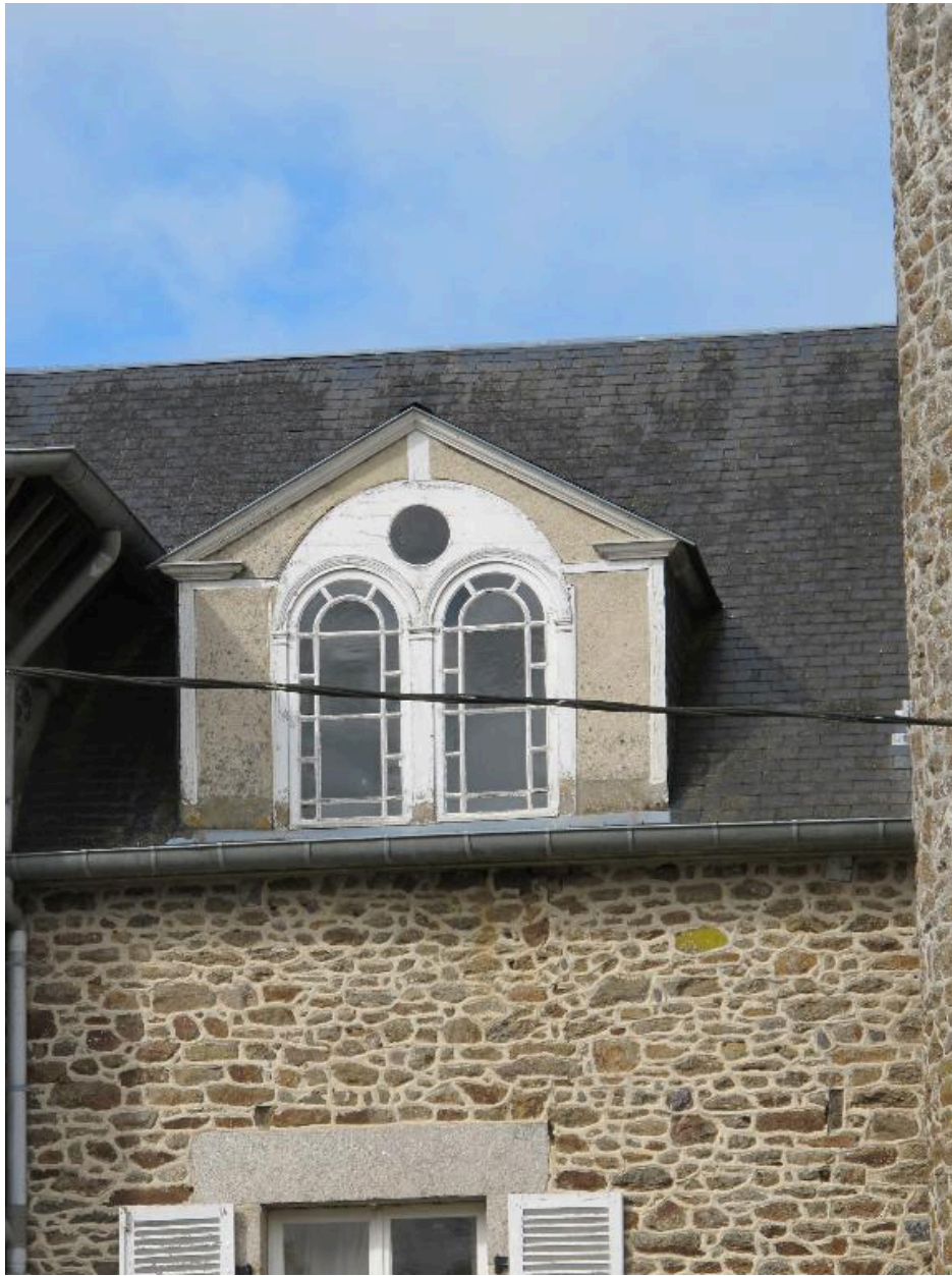
Logis, détail, façade arrière : lucarne
