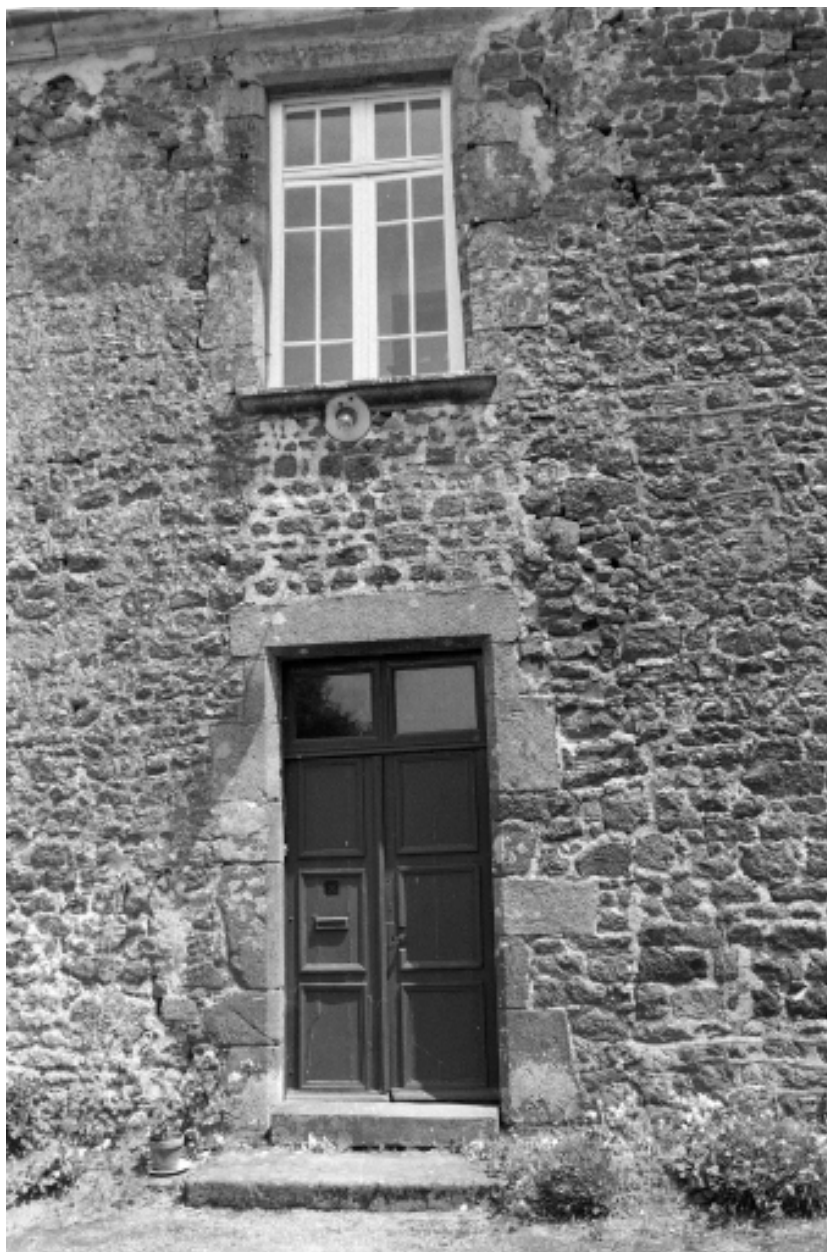
Détail de la façade ouest
