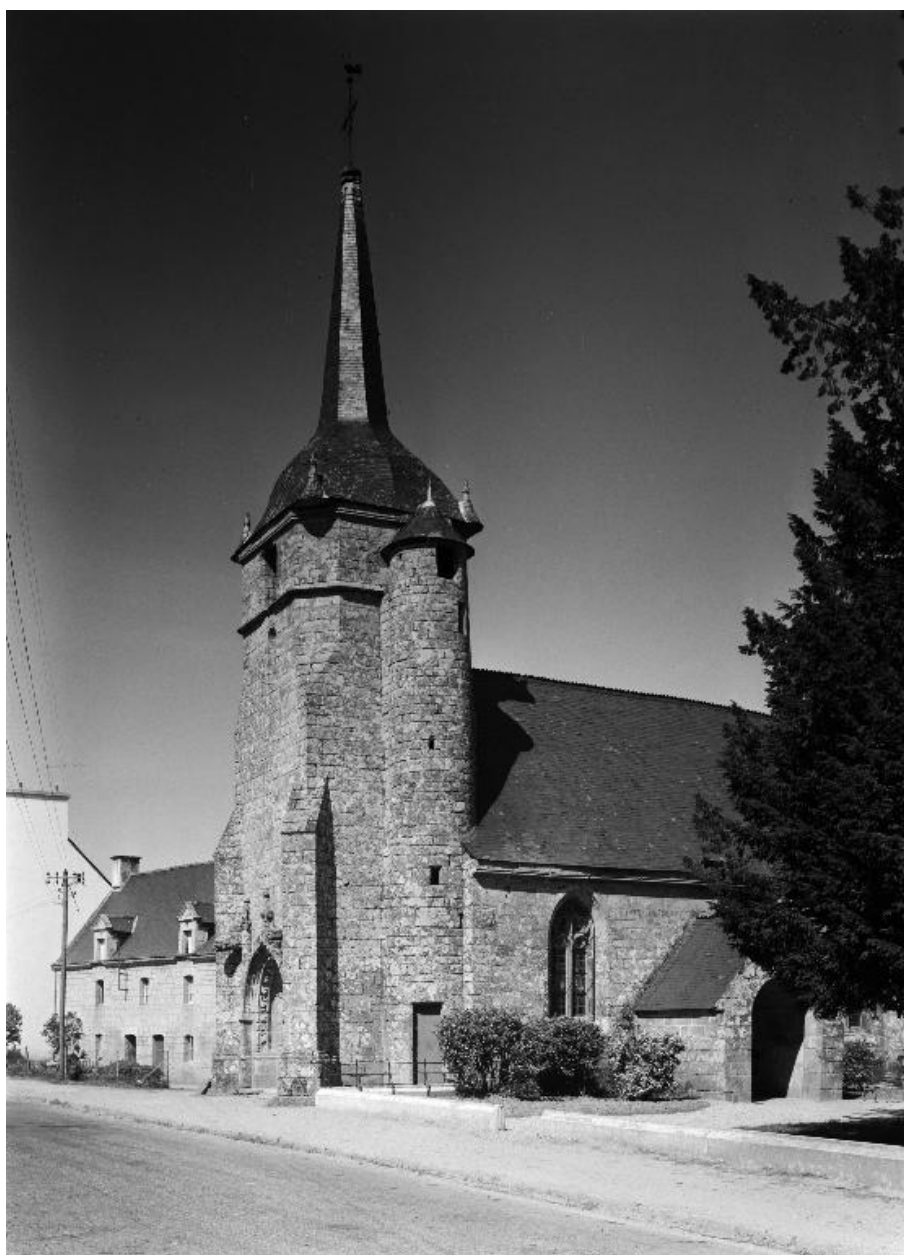
Vue de situation prise du sud-ouest
