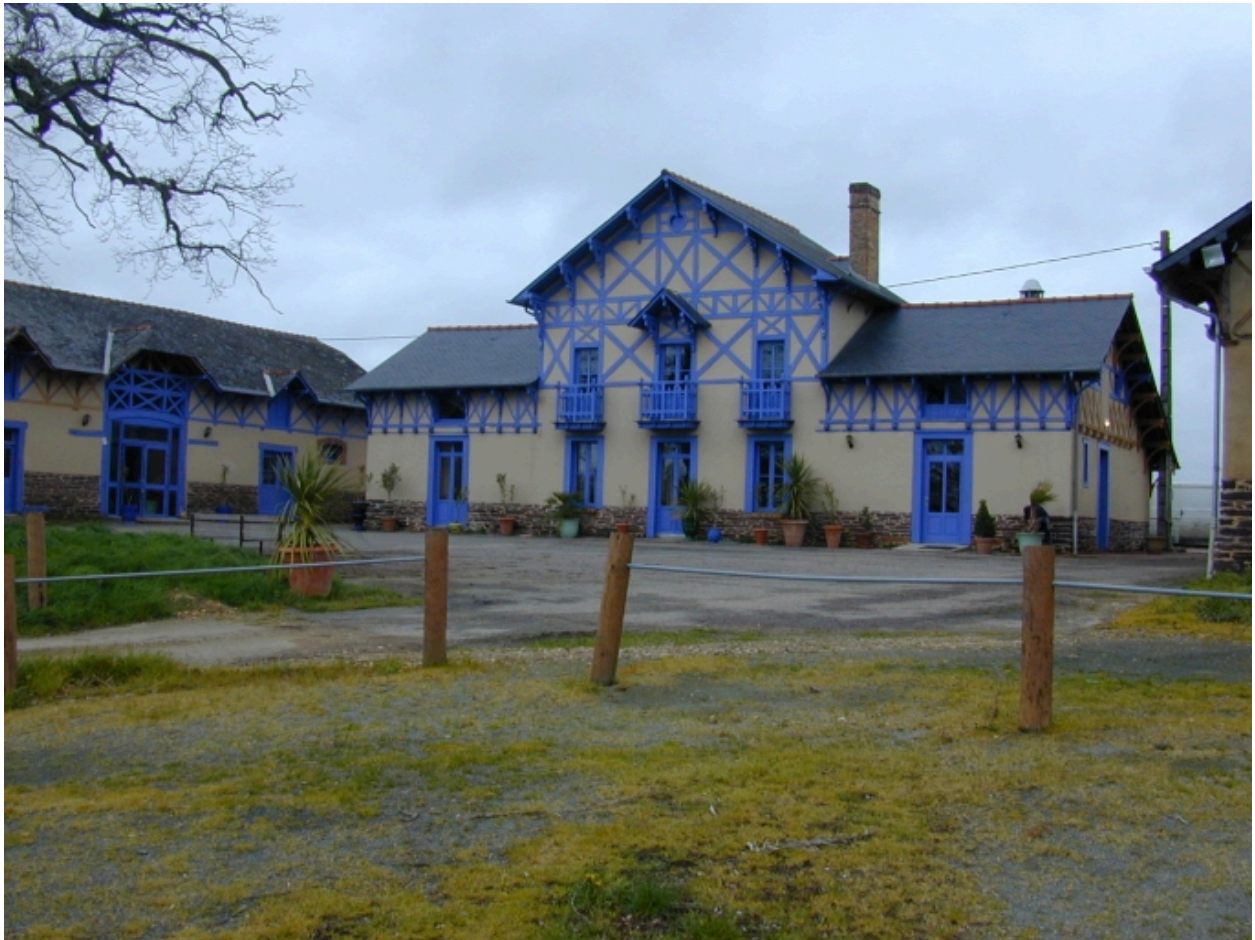
vue générale des communs
