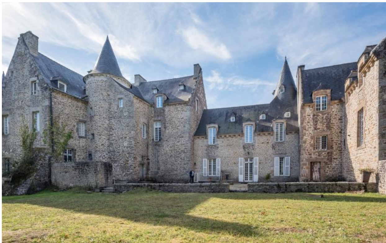
Le manoir, vue générale de la façade arrière
