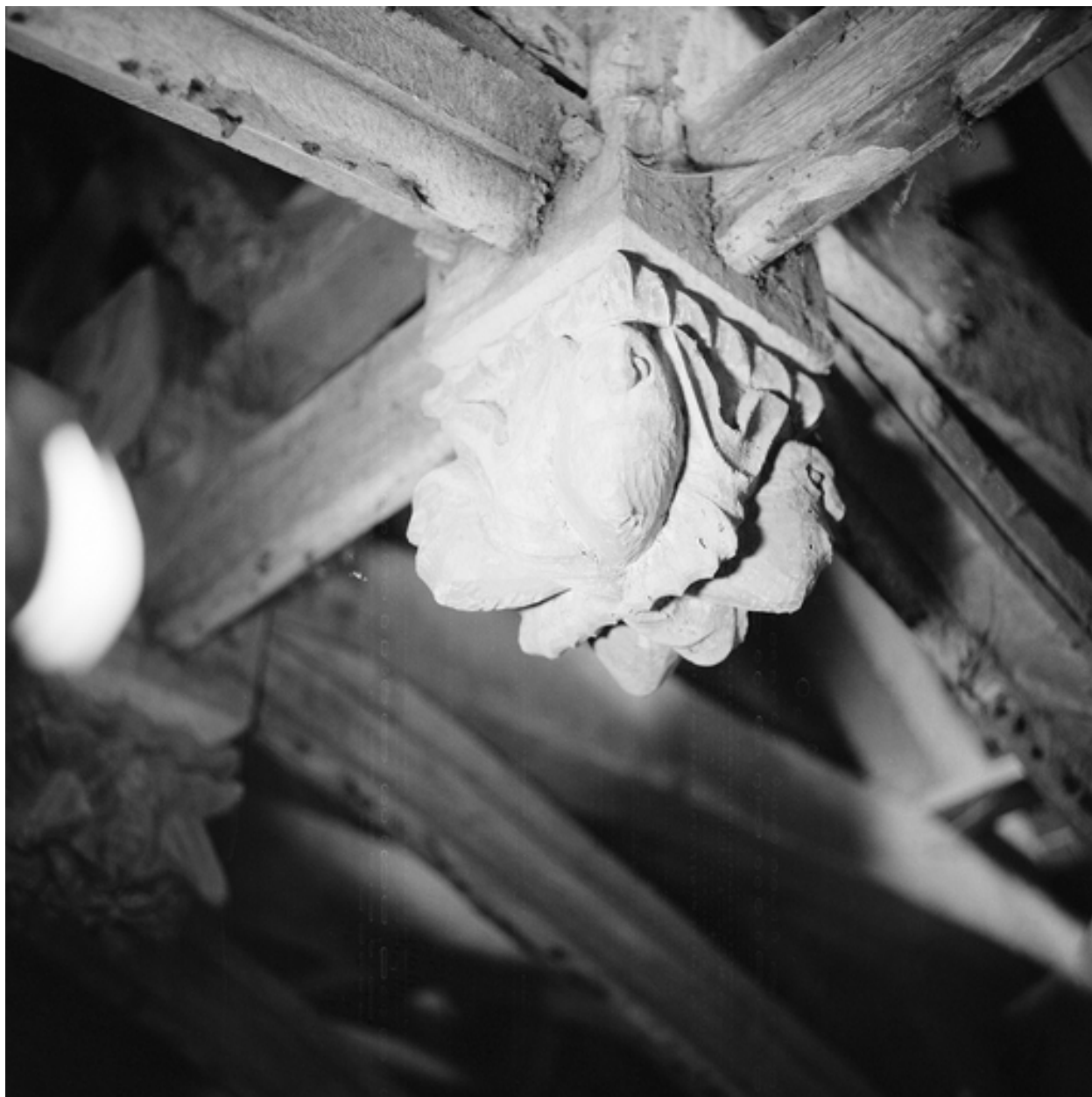
Charpente, détail de la clé 15.
