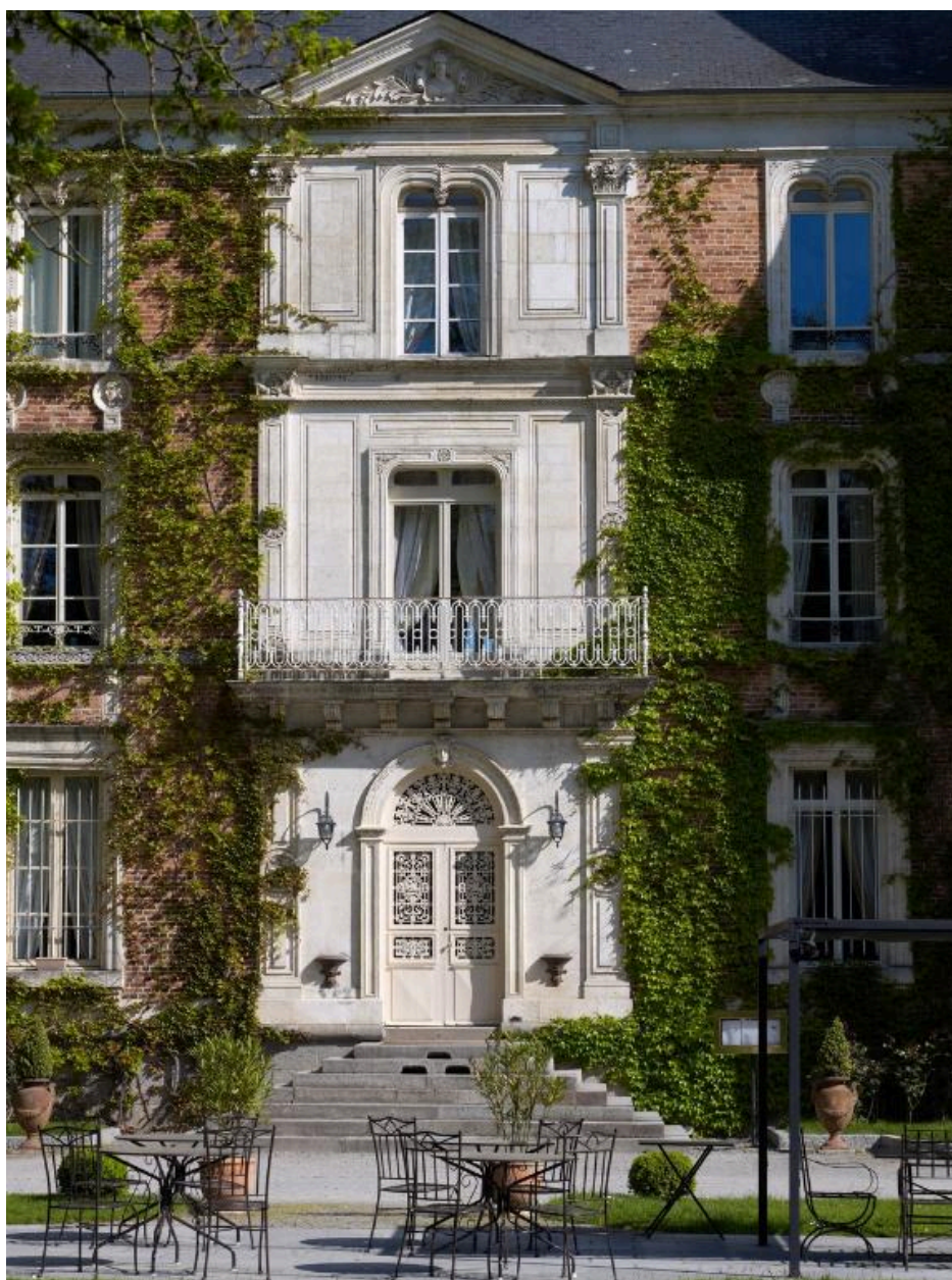
Façade sud, travée centrale
