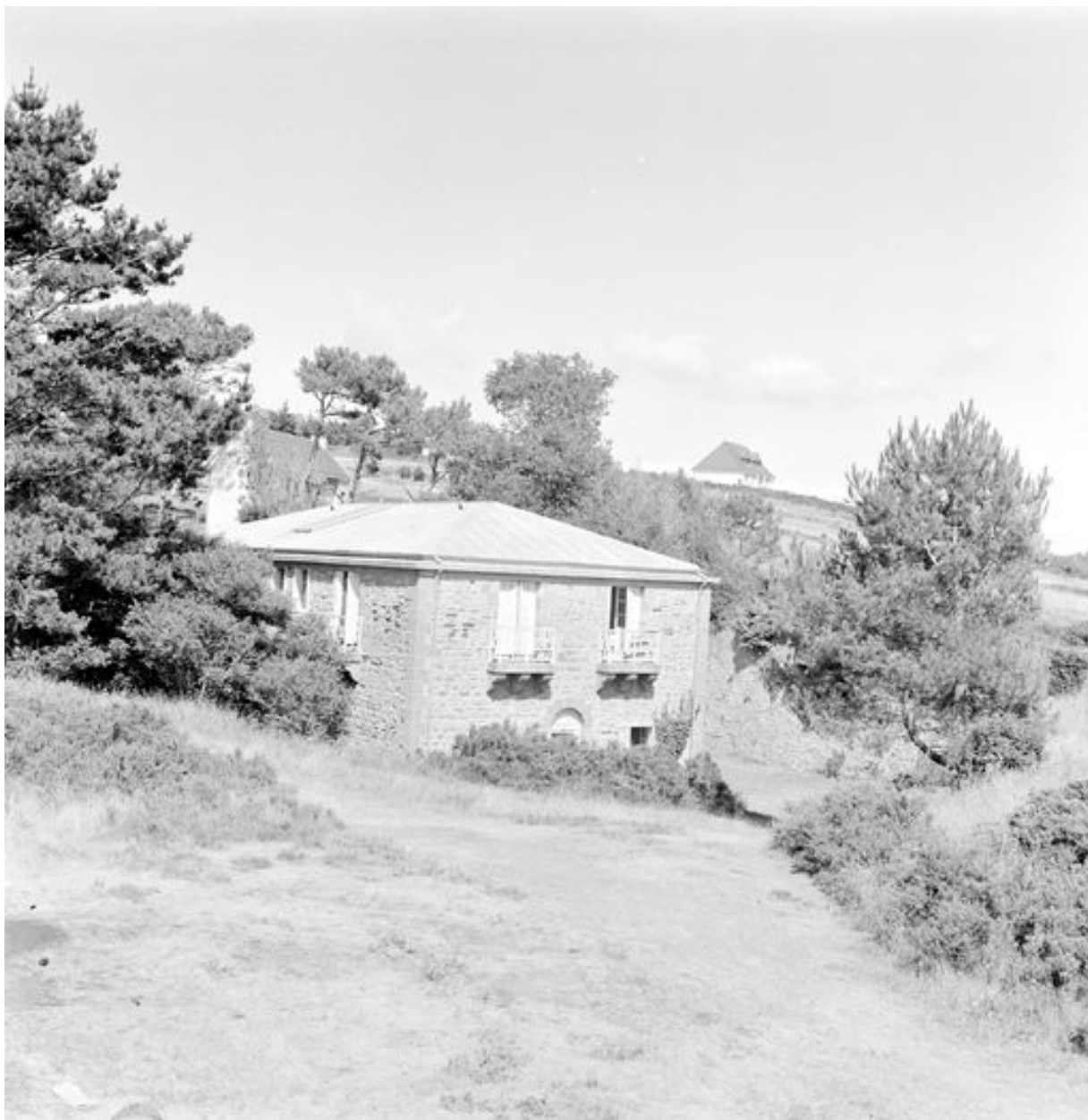
Vue générale du corps de garde crénelé n° 2 de Postolonnec en 1969
